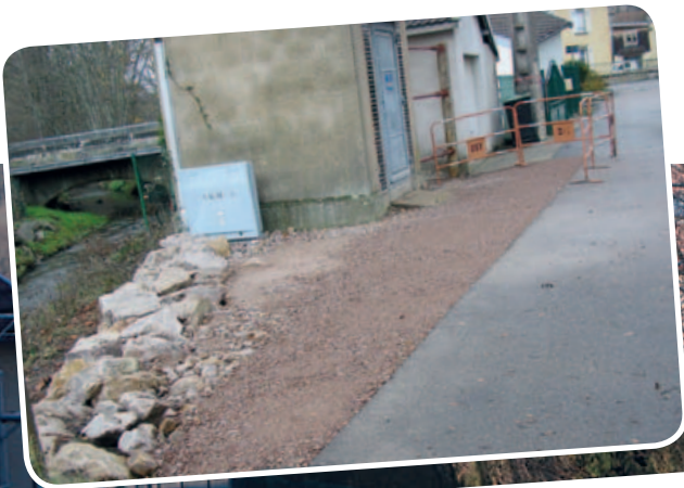
Rue Joli Bois enrochements, découpe d'enrobés, remblaiement
