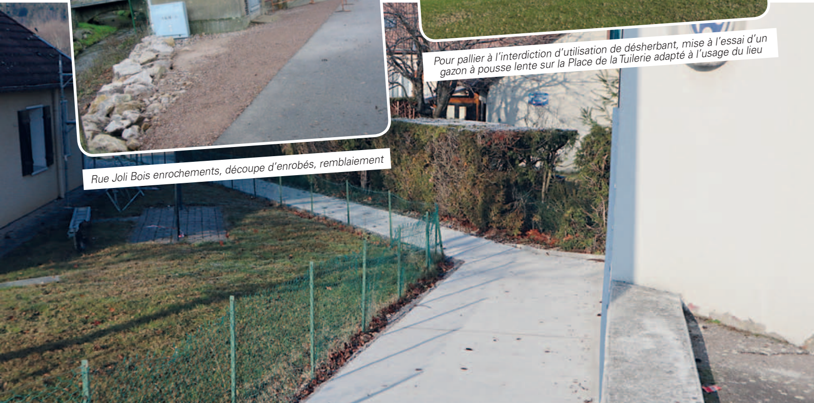
aménagement du sentier piéton allant de la Rue de Lorraine à l'allée du Pré Fériot
