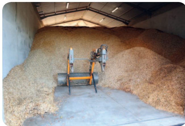
une zone de 900 m 3 pour le stockage des plaquettes de la chaufferie bois
