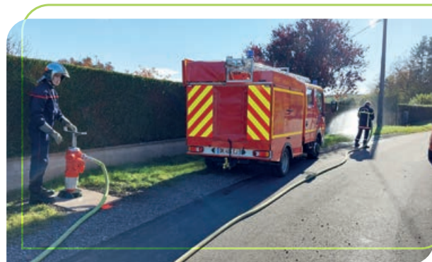
Contrôle Point d'Eau Incendie
