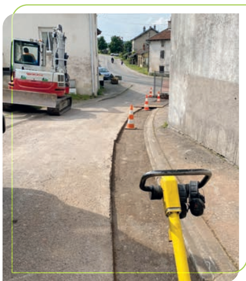
Travaux rue des Lilas
