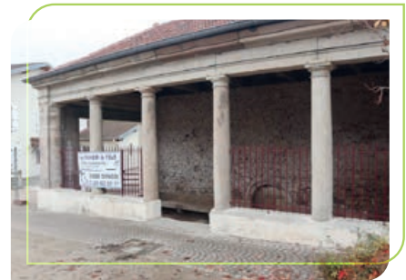
Travaux du lavoir
