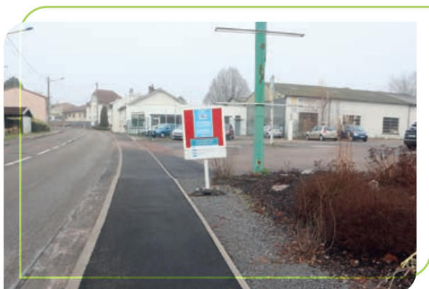
Réfection du trottoir
