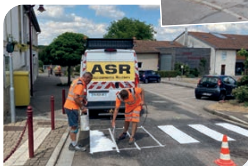
Marquage au sol
