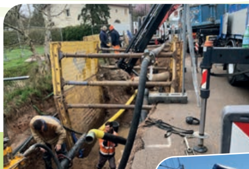
Travaux aqueduc rue du Saint Oger
