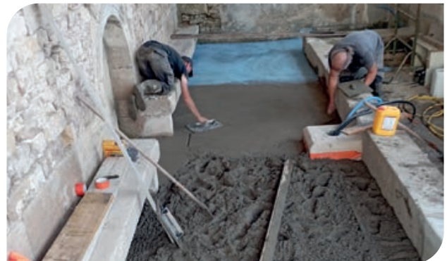
Travaux dans le lavoir
