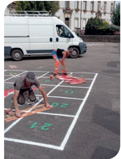
Réfection marquage cour école élémentaire
