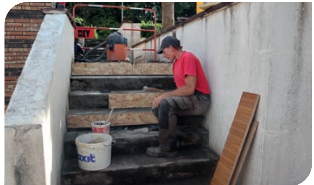
Réfection de l'escalier au CSE
